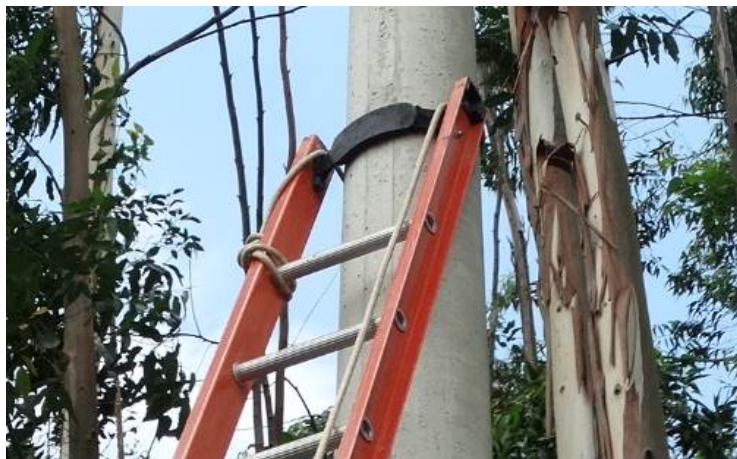
Figura 22 – Posicionamento da escada
