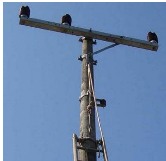
Figura 17 – Ancoragem na ferragem do poste
