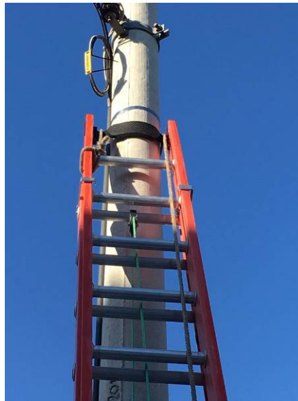
Figura 23 – Posicionamento da escada
