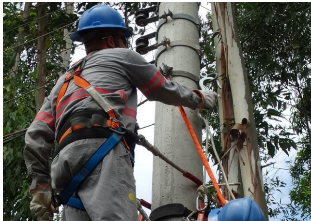
Figura 48 – Fixação do ponto de ancoragem
