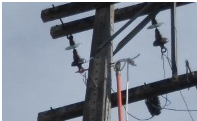
Figura 31 – Instalação do agulhão no poste
