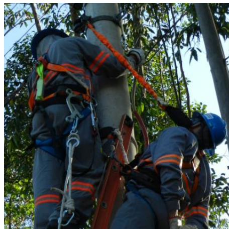
Figura 47 – Socorrista passando o talabarte de posicionamento
