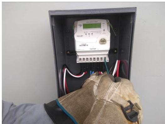
Figura 3 – Retirada do condutor de saída
