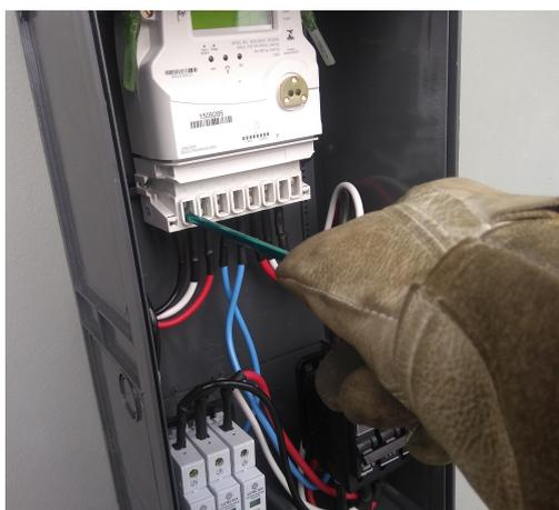
Figura 1 – Retirada do condutor de entrada
